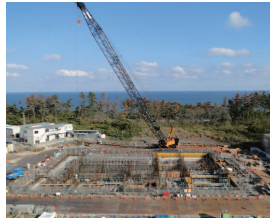
▲大洗研究開発センターにて新たに建設中の固体廃棄物減容処理施設(OWTF)
