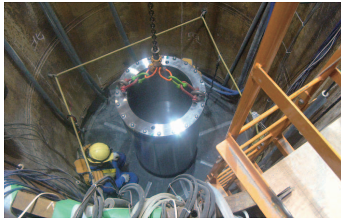
▲模擬オーバーバックの設置の様子(幌延)
